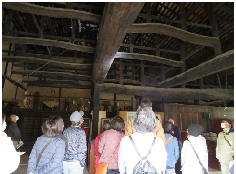
特別公開で後藤家住宅内部を見学 縦横に走る梁がみごと
